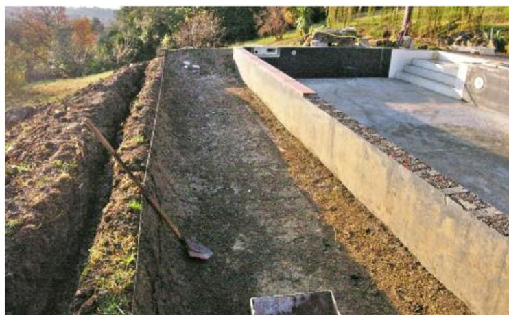
In questo progetto, per realizzare la fitodepurazione è stata sbancata un'area a lato della piscina, senza ridurre le dimensioni dell'area balneabile; si è anche provveduto a risollevarla per dotarla di drenaggi, in quanto non erano stati previsti nella configurazione originale.
